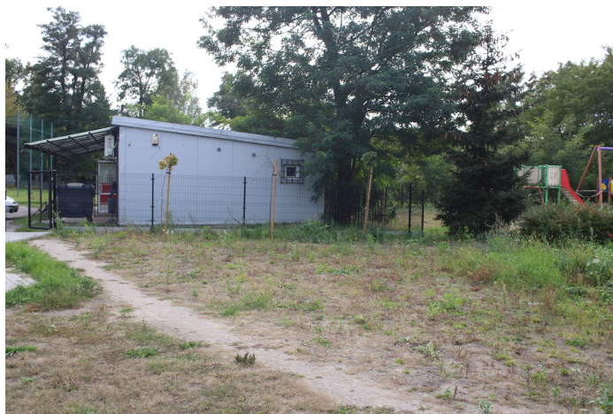
Fot. 1 Miejsce montażu urządzeń
